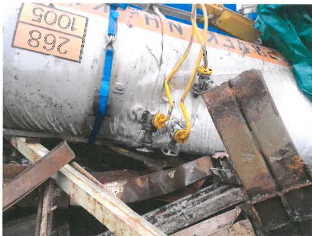
Uvolnění boku nádrže a odstranění zbytků krytu ventilů
