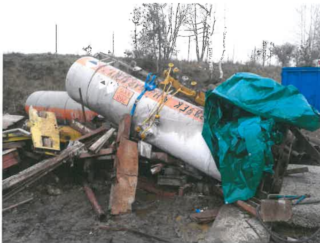
Uvolnění boku nádrže a odstranění zbytků krytu ventilů
